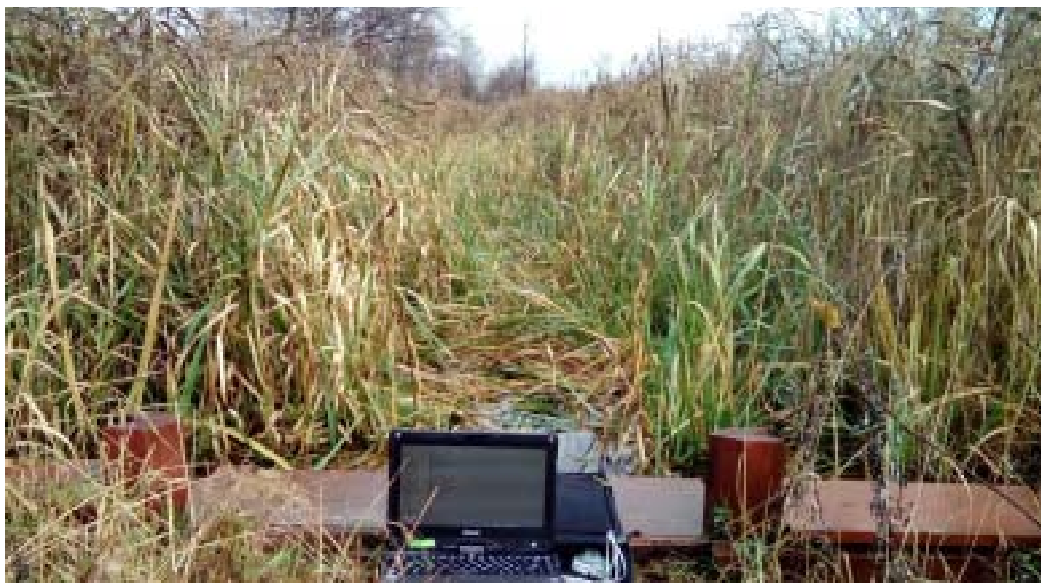
Fot. Rów spod Polkowa powyżej budowli numer 1, październik 2017 (fot. J. Zawadzka).
