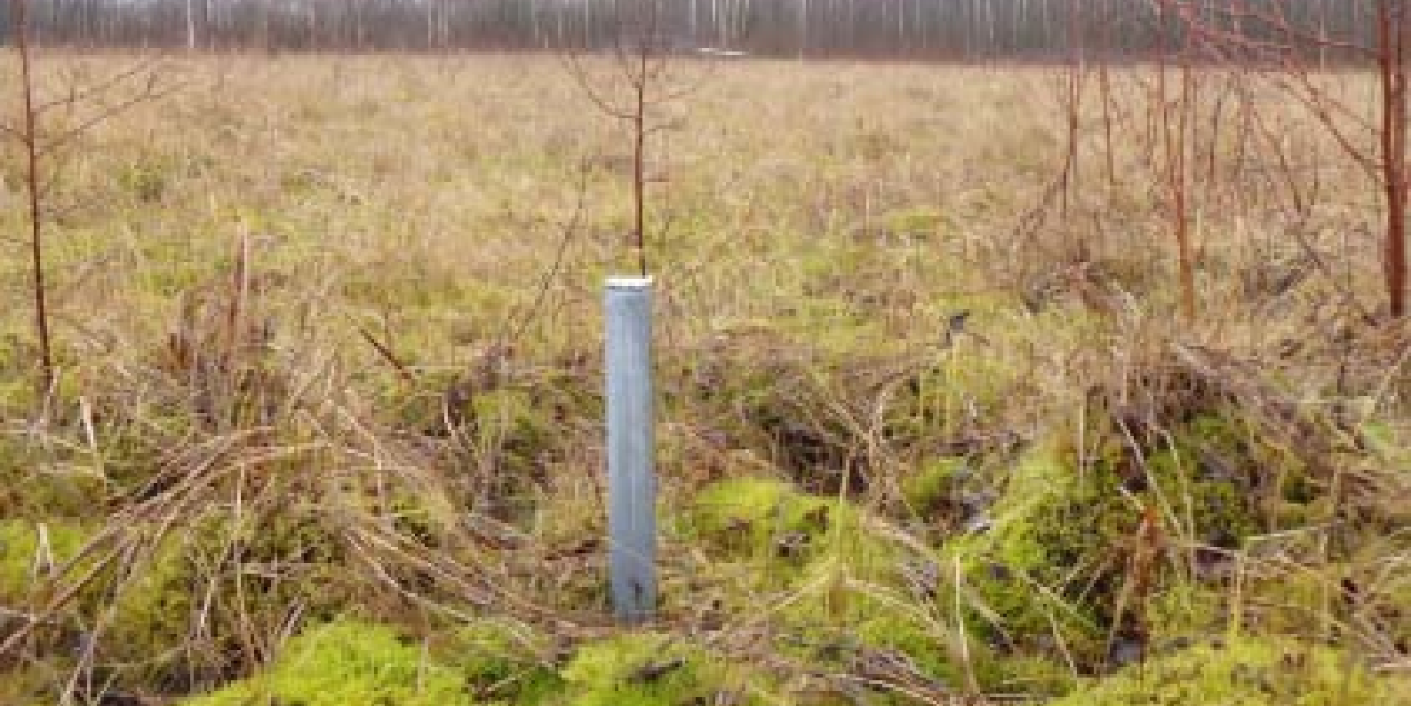
Fot. Zainstalowany piezometr nr 268, grudzień 2017 (fot. Adam Bernatowicz).
