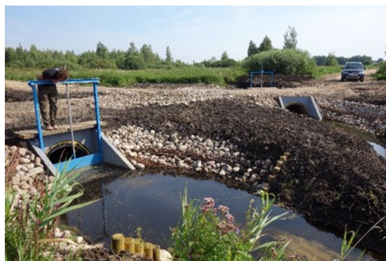
Fot. Przepust z piętrzeniem w okolicy wsi Szuszałewo, fot. A. Bojsza.
