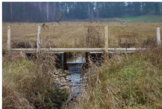
Fot. Zastawka na rowie w okolicy wsi Kamienna Stara, fot. A. Bojsza .
