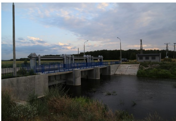
Fot. 2. Wyremontowany jaz od strony północnej, sierpień 2019, fot. Adam Bernatowicz
