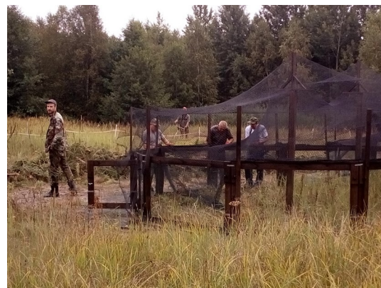
Fot. 1. Budowa stanowiska adaptacyjnego dla cietrzewi, 20.08.2019 (fot. K. Henel)
