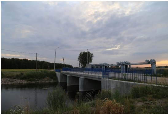
Fot. 1. Wyremontowany jaz od strony południowej, sierpień 2019, fot. Adam Bernatowicz
