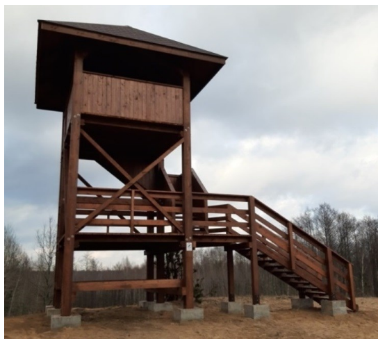
Fot. Nowa wieża widokowa na "Wilczej Górze" (grudzień 2019), fot. G. Wroceński
