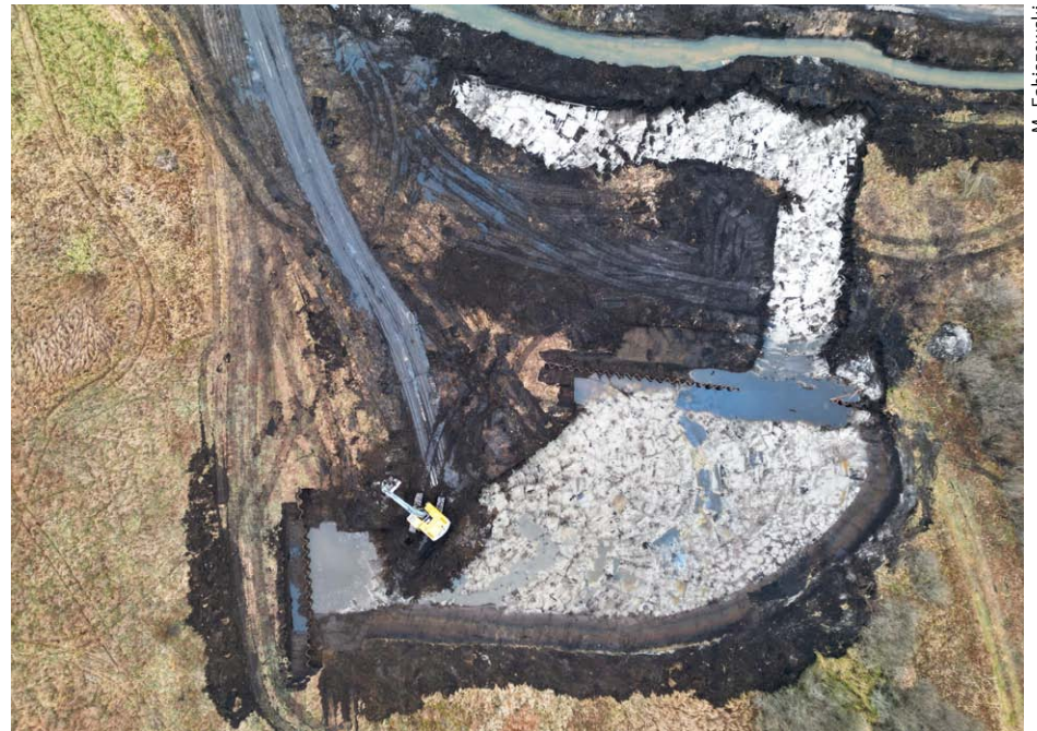
Prace na węźle wodnym Modzelówka, 2023
