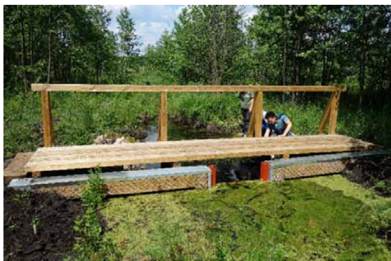
RYC. 8. ZASTAWKA NA ROWIE ODWADNIAJĄCYM W SZUSZALEWIE
