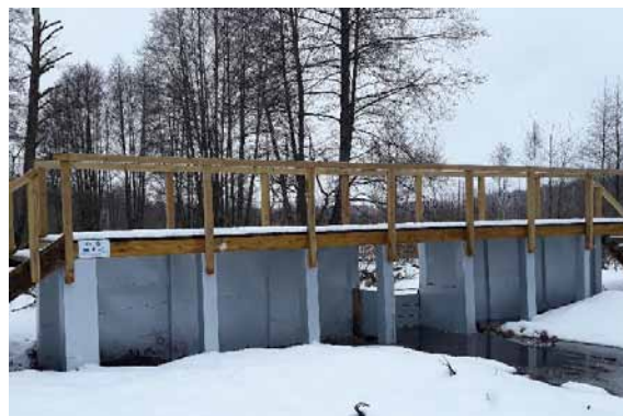
FOT. 1 I 2. JEDEN Z NOWYCH PROGÓW PIĘTRZĄCYCH I ZASTAWKA NA KANALE KAPICKIM, FOT. J. ZAWADZKA
