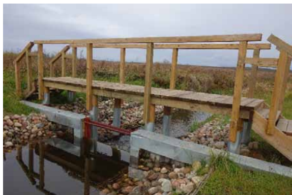
RYC. 8. ZASTAWKA NA ROWIE ODWADNIAJĄCYM W SZUSZALEWIE
