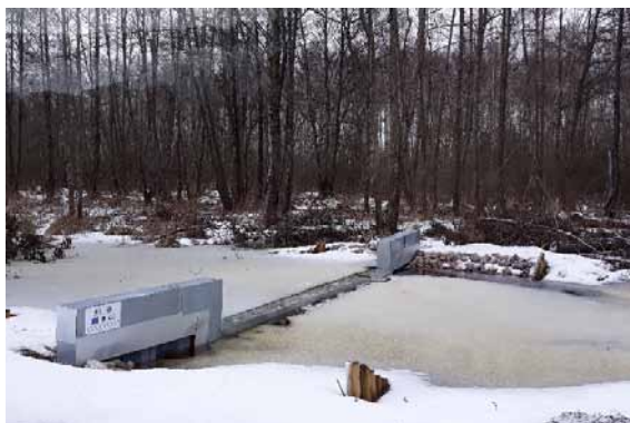
FOT. 1 I 2. JEDEN Z NOWYCH PROGÓW PIĘTRZĄCYCH I ZASTAWKA NA KANALE KAPICKIM, FOT. J. ZAWADZKA
