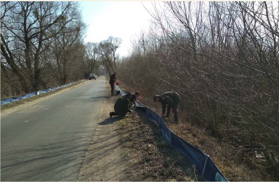
Montaż ogrodzeń herpetologicznych na odcinku drogi między Goniądzem a Wólką Piaseczną
