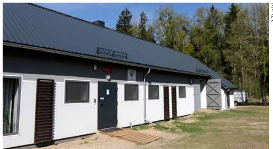
Gabinet weterynaryjny w ORZ na Grzędach, wyremontowany ze środków funduszu leśnego Lasów Państwowych
