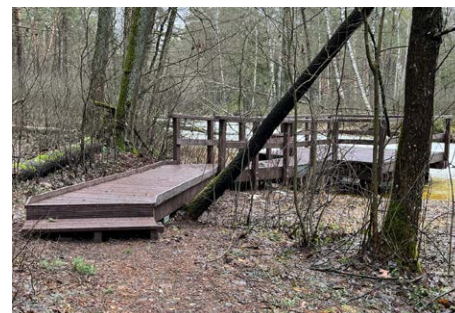
Remonty infrastruktury turystycznej BbPN - platforma Fort IV
