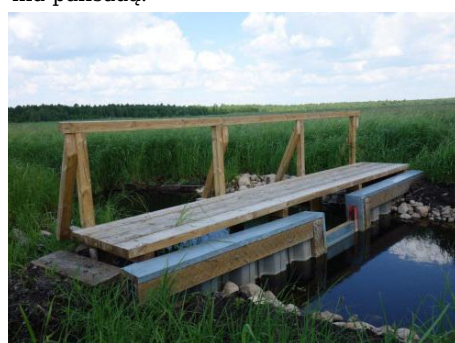
Zastawka piętrząca na rowie odwadniającym
