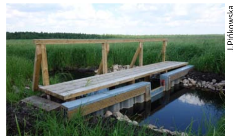
Zastawka – budowla piętrząca służąca do zatrzymania wód spływających z torfowiska (Kamienna Nowa)
