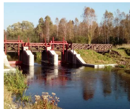
Rozrząd wód na Kanale Woźnawiejskim za pomocą jazu
